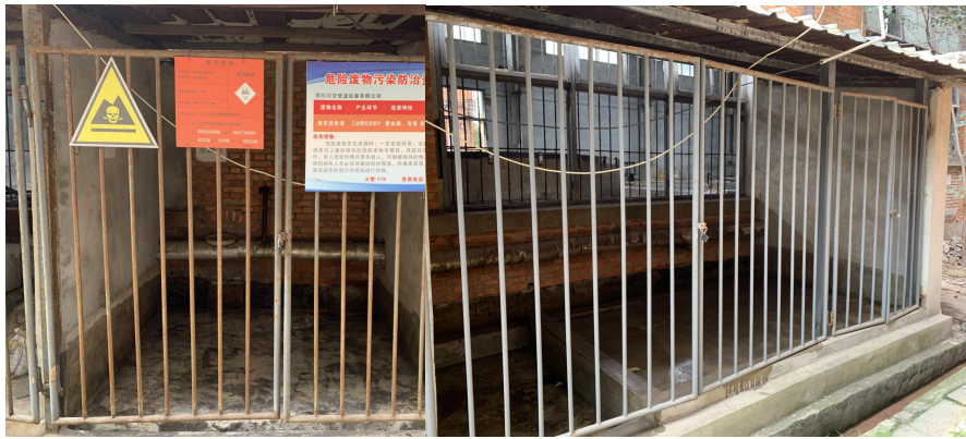
图 3-2 四川川空低温设备有限公司危废暂存间现状
